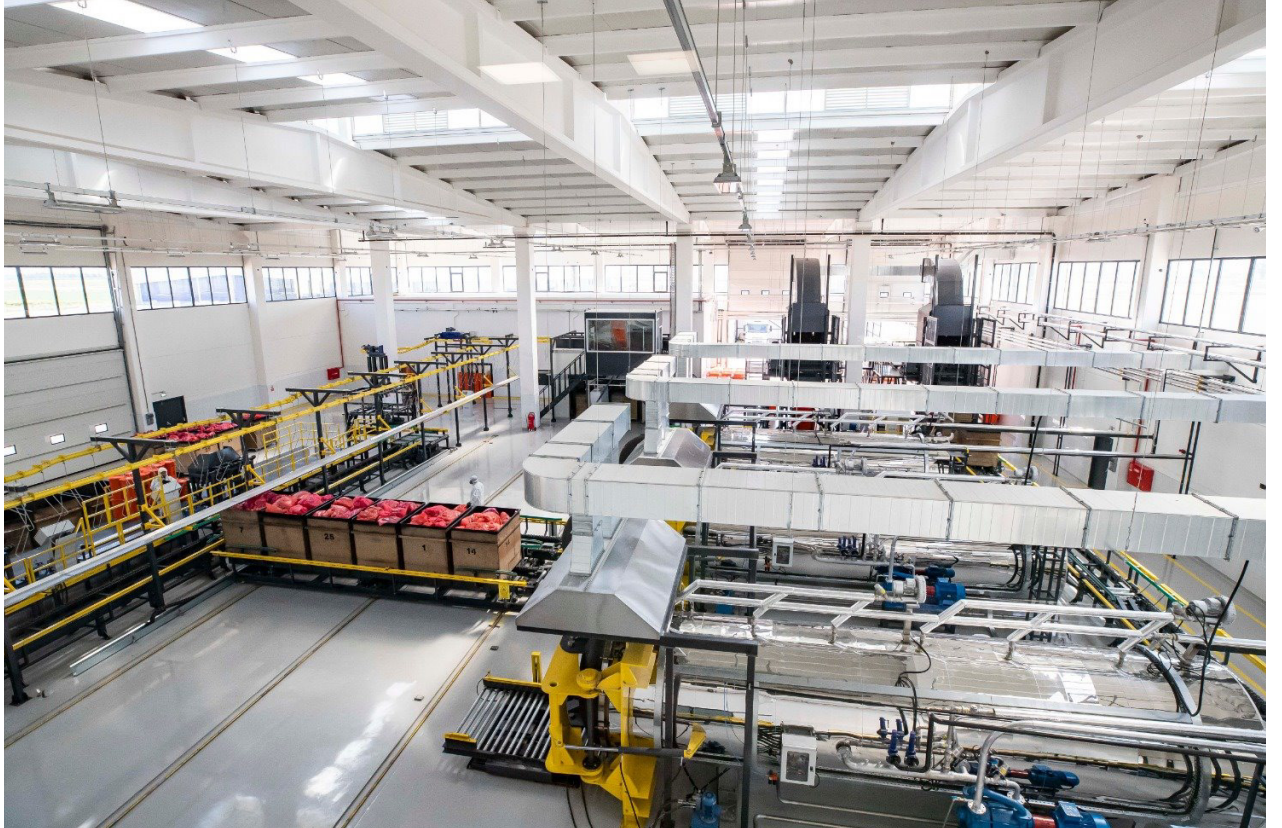
Tıbbi Atık Sterilizasyon Tesisi
