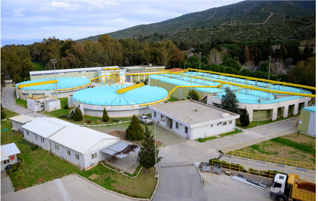
Güneybatı İleri Biyolojik Atıksu Arıtma Tesisi
