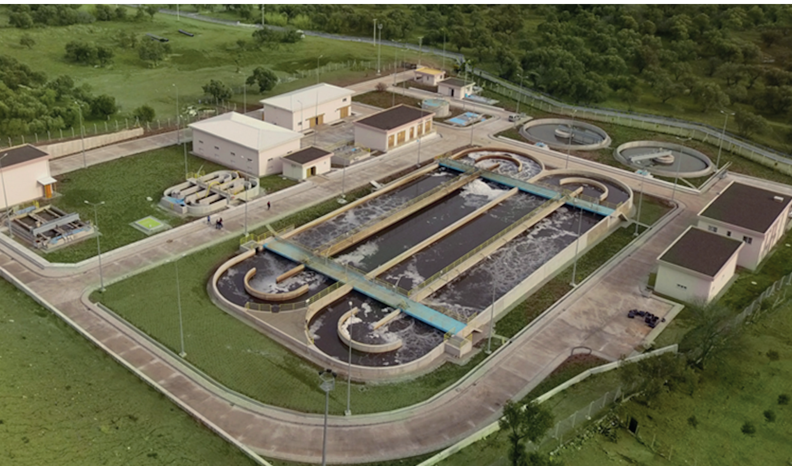
Çiğli Atık Su Arıtma Tesisi
